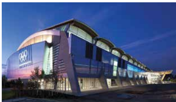
Juegos Olímpicos de Invierno 2010, Vancouver, Canadá | Sistema simple de Fachada de 16mm | Arquitecto: ING
